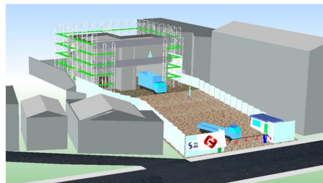
③ 石綿含有建材撤去・内装解体工事
